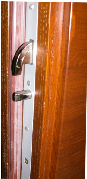
Detail : Verriegelung einer Haustür
