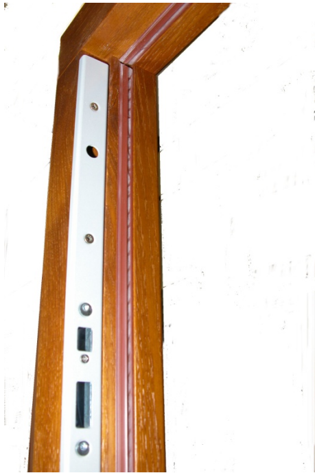
Detail: Schließleiste einer Haustür
